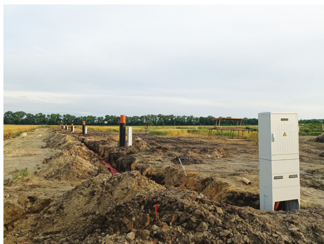
Budování inženýrských sítí v lokalitě „Za hřištěm“
